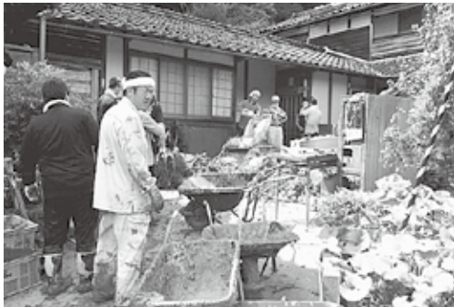
土砂の運搬作業などを行う県本部のボランティア
