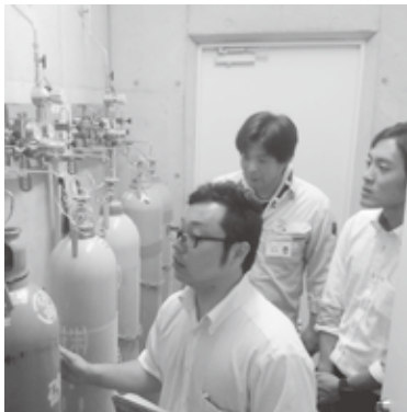
西宮市越水浄水場の点検を行う
