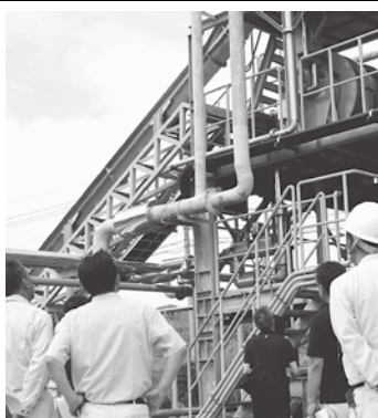
消化ガスタンクを点検中
