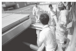
伊丹市千僧浄水場を点検
